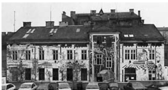
Sgraffito Alchemia, 1983. Gestaltung der Fassade des Stadtwerkstatt-Hauses mit alchemistischen Motiven in der traditionellen Sgraffito-Technik mit Strohasche und Kalk.
